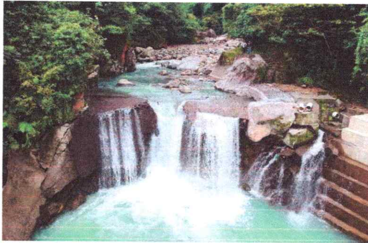
Ilustración 6 Estado de la estructura bocatoma de fondo actualmente
