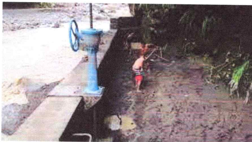
Ilustración 8 Estructura de captación lateral existente
