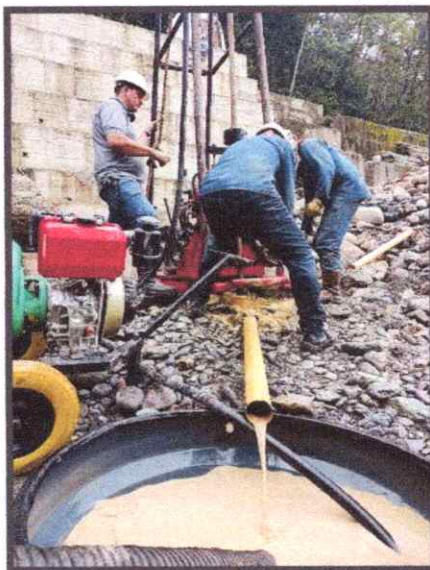
INSTALACION REBESTIMIENTO (NW) RECUPERACION DE MUESTRAS DE ROCA
