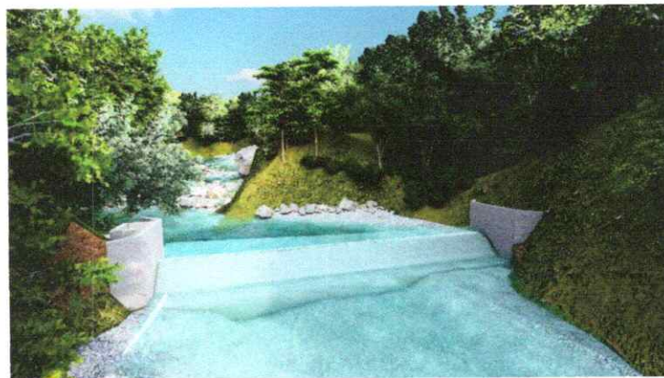
Ilustración 5 Bocatoma de fondo
