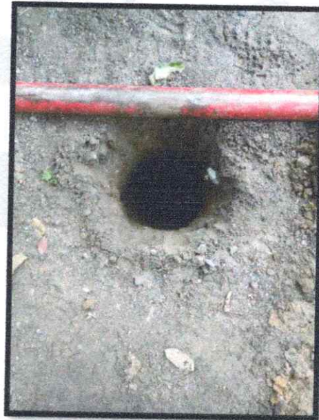
MUESTRA OPTENIDA MEDIANTE SPLIT SPOOM DETALLE APIQUE/SONDEO
