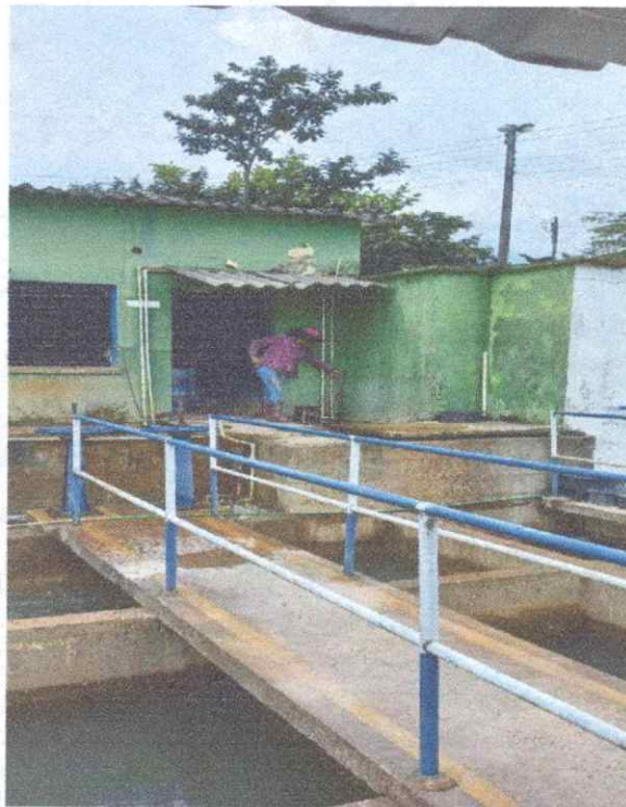
Figura 4 Levantamiento topográfico canaleta parshall
