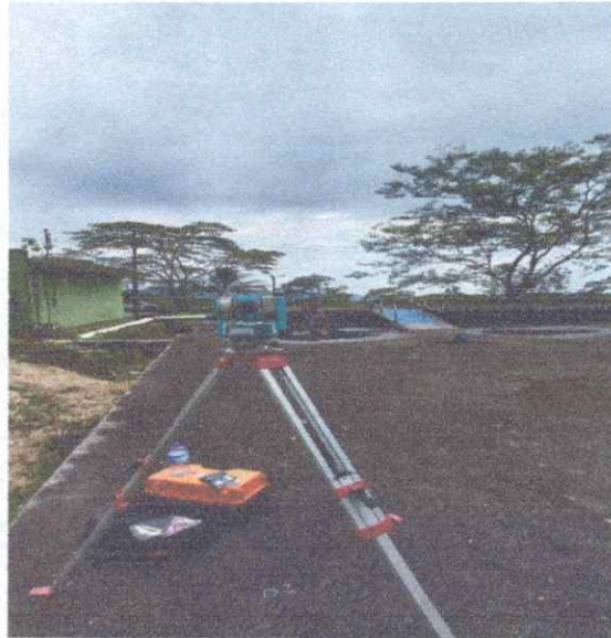
Figura 5 Levantamiento topográfico toma de punto tanque 2
