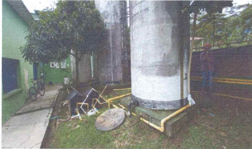
Figura 7 Levantamiento topográfico toma de punto cerramiento
