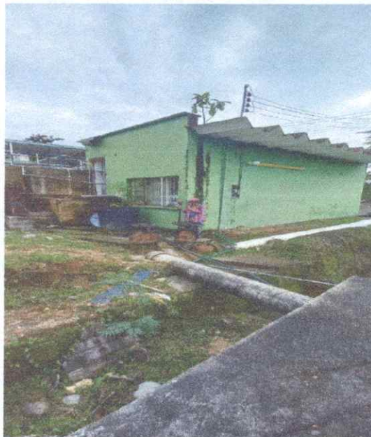
Figura 6 Levantamiento topográfico toma de punto valvula
