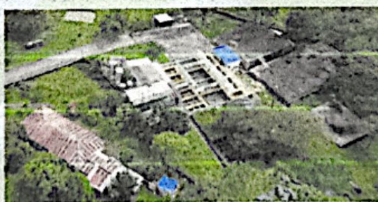
Fotografía 3. Planta de tratamiento de agua potable Las Blancas
