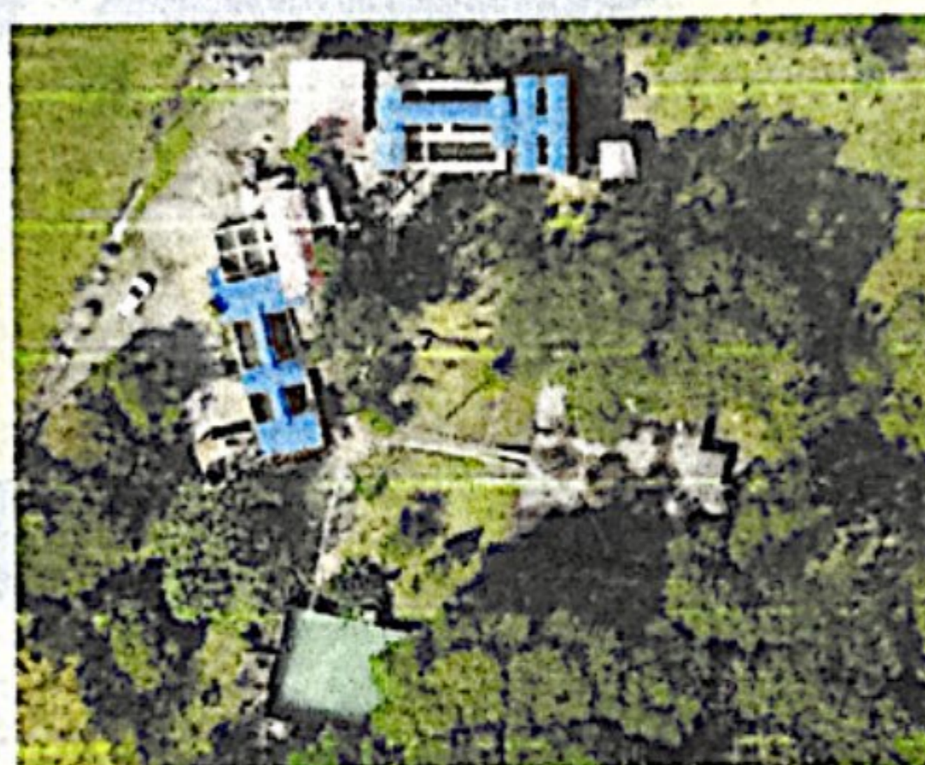
Fotografía 2 Planta de tratamiento de agua potable Acacitas
