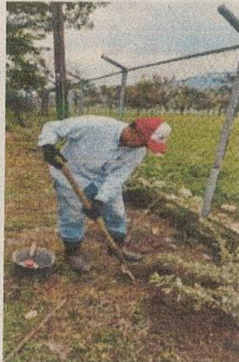
Ilustración 5 Construcción de GPS 01
