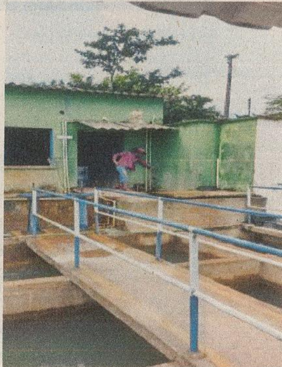
Figura 4 Levantamiento topográfico canaleta parshall
