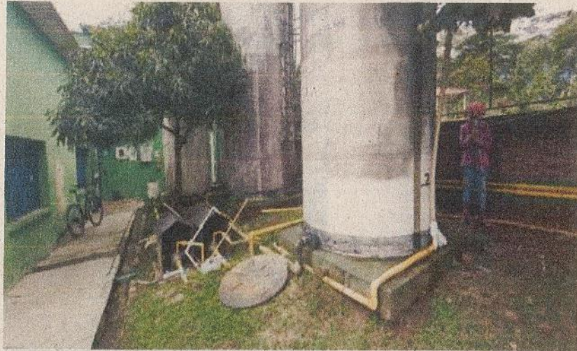
Figura 7 Levantamiento topográfico toma de punto cerramiento
