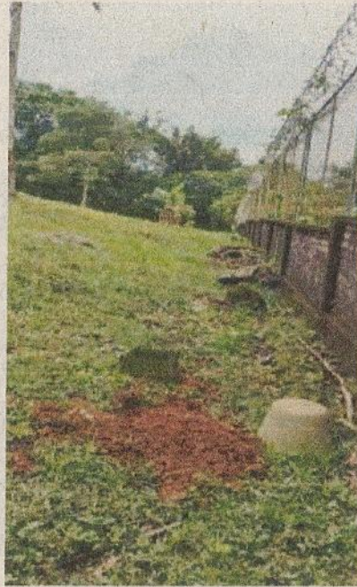
Ilustración 6 Construcción de gps 02
