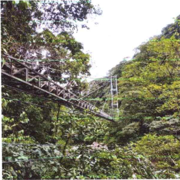
Vista general del viaducto, con un sistema atirantado, compuesto por una torre central y un sistema simétrico, con luces a lado y lado de la torre de aproximadamente 72.00 m de longitud.
