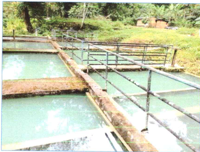
Ilustración 3 Desarenador del sistema de captación quebrada Las Blancas
