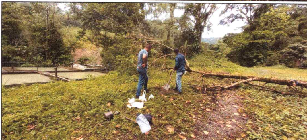
Sondeos realizados en el sector del desarenador
