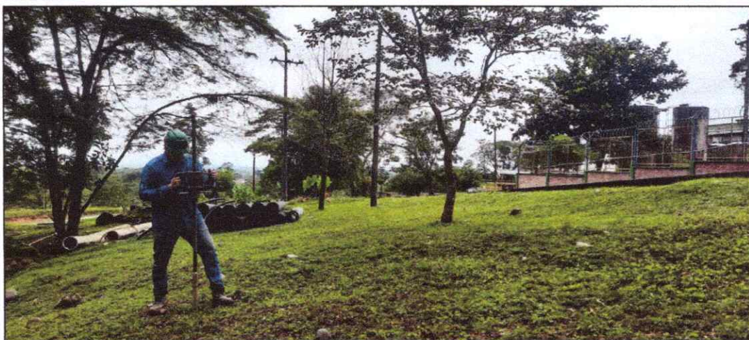
Sondeos realizados en el sector del tanque elevado
