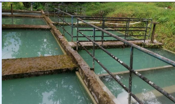
Ilustración 2. Estructura existente Desarenador sistema Las Blancas.
