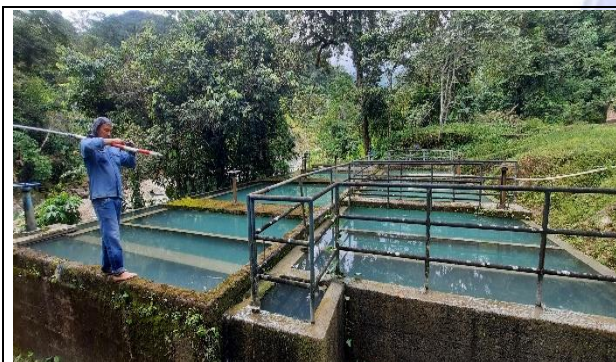
Ilustración 1. Estructura existente Desarenador sistema Las Blancas.
