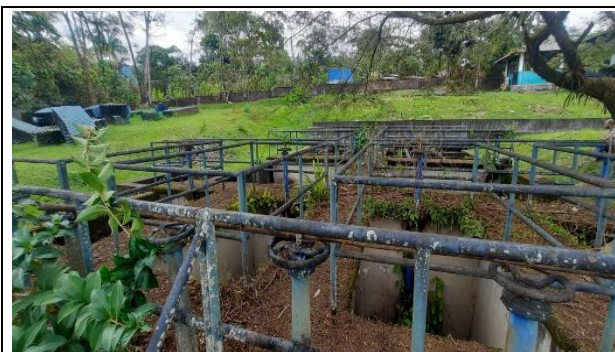
Ilustración 5. Estructuras existentes PTAP Las Blancas
