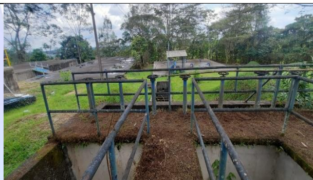
Ilustración 6. Estructuras existentes PTAP Las Blancas
