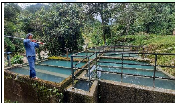
Ilustración 1. Estructura existente Desarenador sistema Las Blancas.
