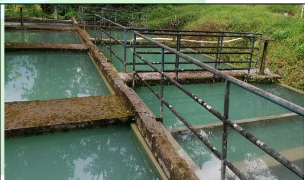
Ilustración 2. Estructura existente Desarenador sistema Las Blancas.
