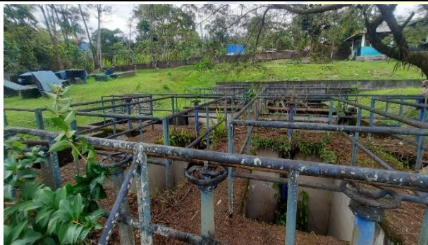
Ilustración 5. Estructuras existentes PTAP Las Blancas
