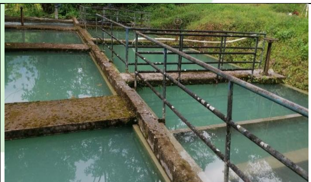
Ilustración 2. Estructura existente Desarenador sistema Las Blancas.
