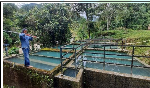
Ilustración 1. Estructura existente Desarenador sistema Las Blancas.
