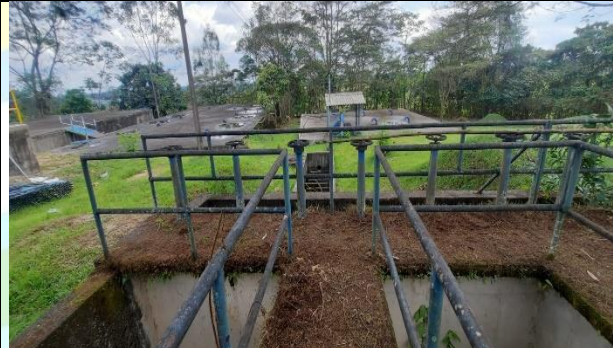
Ilustración 6. Estructuras existentes PTAP Las Blancas
