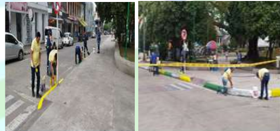
Inspección señalización actividad de limpieza y pintura contiguo parque principal
